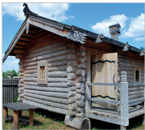
Будинок зі зрубу (реконструкція)
